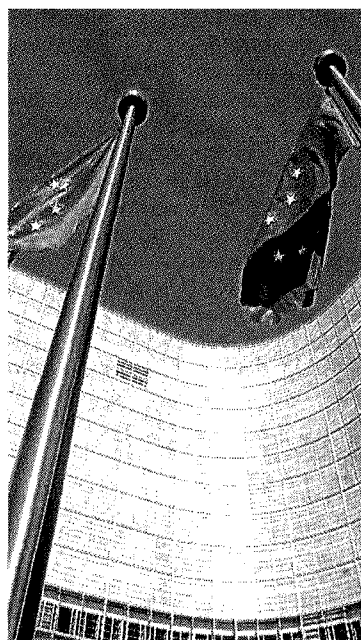
La sede della commissione Ue
